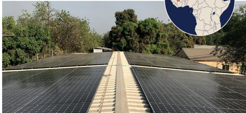
La solution conçue par Tysilio optimise la production solaire sur un espace de toiture réduit avec des modules photovoltaïques hautes performances. Un dispositif zéro export, demandé par l'EUTM circonscrit la production en énergie au besoin du bâtiment. La réalisation du chantier a été conduite par l'équipe franco-malienne de Tysilio pour une mise en service effective 4 mois après l'attribution du marché.
